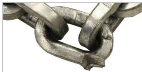
Kättinglänken har mekaniska skador.
